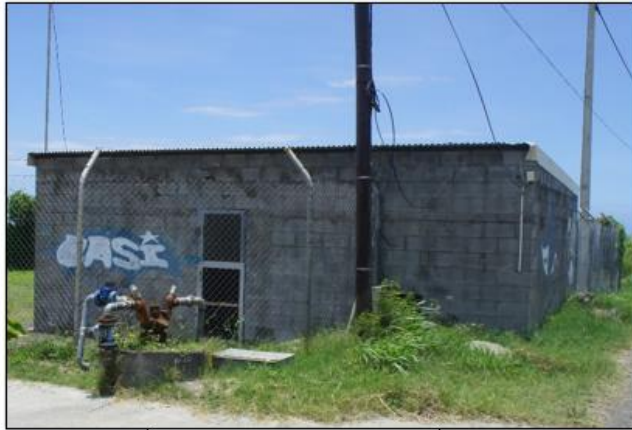
Chambre de vanne
